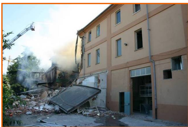
Corpo centrale dell'edificio in via Torino
