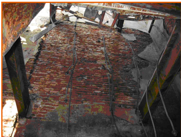
Silos-fariniera in legno all'interno del mulino
