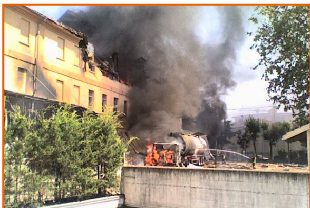
Corpo centrale dell'edificio, autocisterna in fiamme e cortile interno del molino, visti dal condominio di fronte, in via Paglieri
